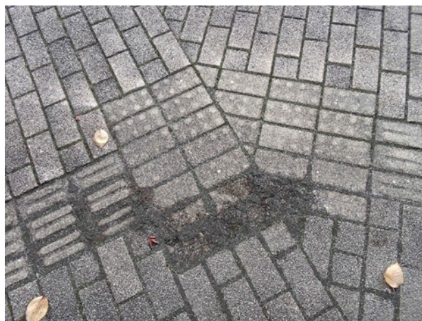
図-13 警告ブロック同士の重なり状況②
