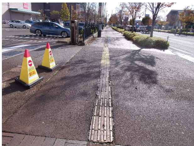
図-19 商業施設駐車場出入口の誘導ブロック
