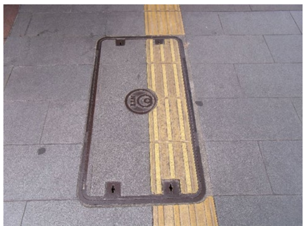
図-4 マンホール上の誘導ブロック設置例
