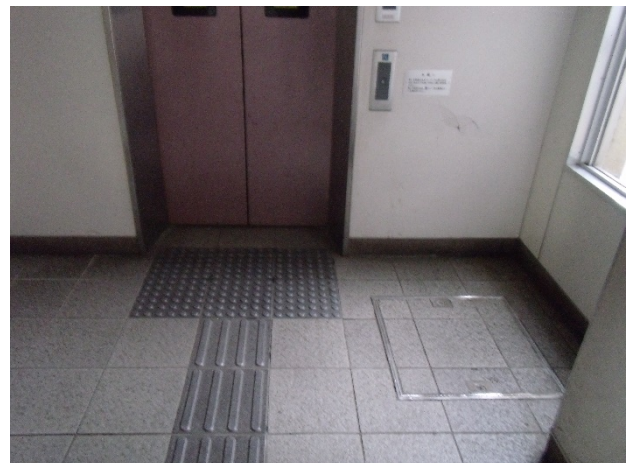
図-16 エレベータ前の誘導ブロック設置状況
