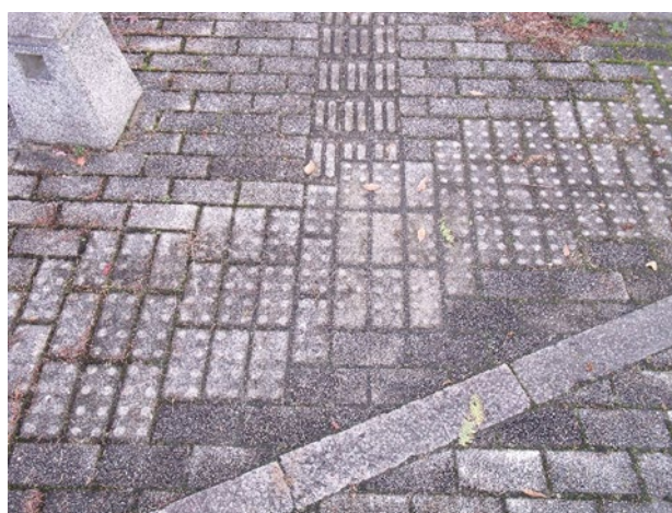
図-9 色彩の混合設置状況
