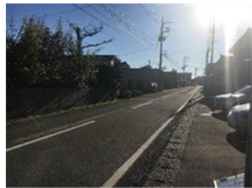
図-5 試験を行った道路の外観
