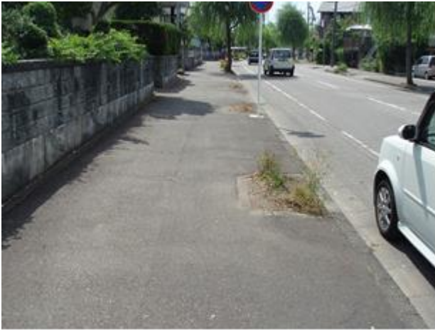
写真 1 無雪時歩道状況（関原上除線・平成 22/8/6）
