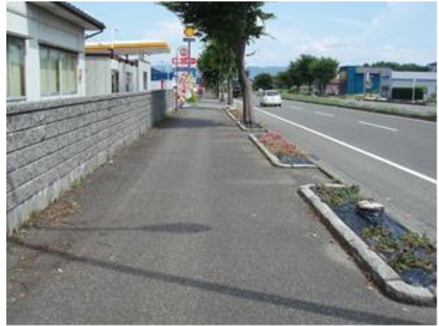
写真 2 無雪時歩道状況（長岡バイパス・平成 22/8/6）
