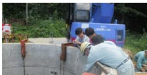
図-6 排水ボーリングの施工現場視察
