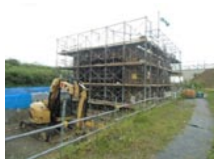
図-5 BOXカルバート施工現場の例
