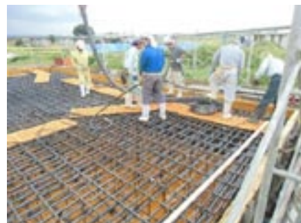
図-6 締固めの様子
