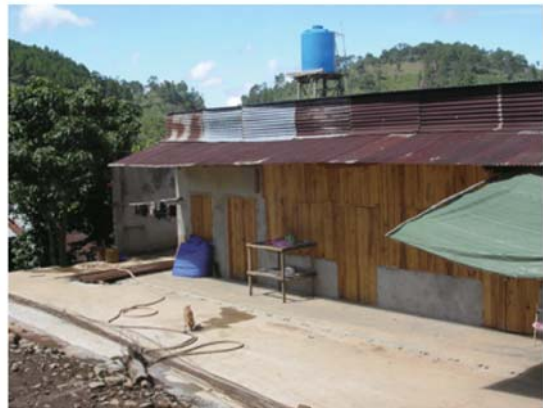
写真-12 水道タンク
