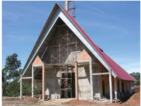
写真-10 建設中の教会
