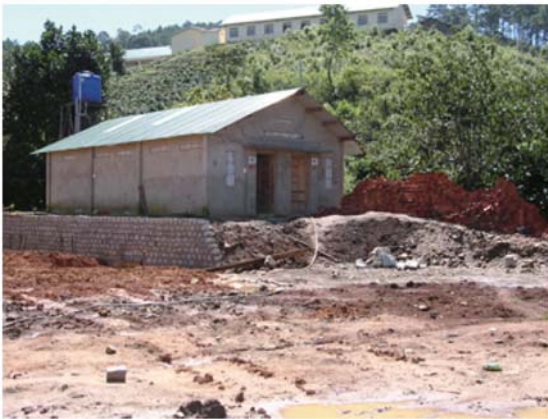
写真-11 完成間近のトイレ
