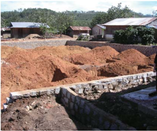
写真-9 寺子屋の基礎工事の様子
