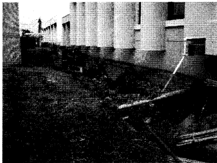
写真-6. 情報処理センターと図書館の南面; ケーブル類の切断
