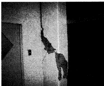
写真-17, 18. 寄宿舍4号館と隣接するホールの柱のせん断破壊
