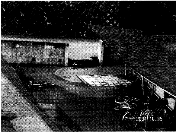
写真-10. 自転車置き場のブロックの孕み
