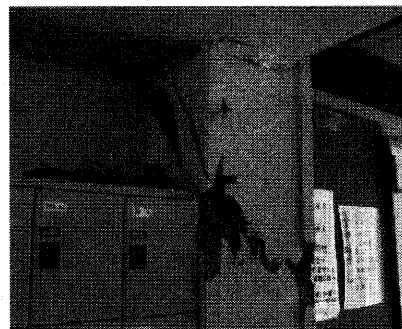
写真-17, 18. 寄宿舍4号館と隣接するホールの柱のせん断破壊
