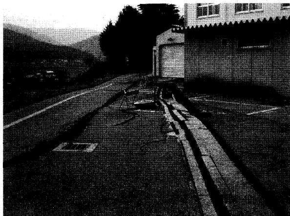
写真-20. 北東側構内道路のクラック
