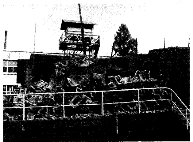
写真-16. 南倉庫南側のブロック積み擁壁の崩壊
