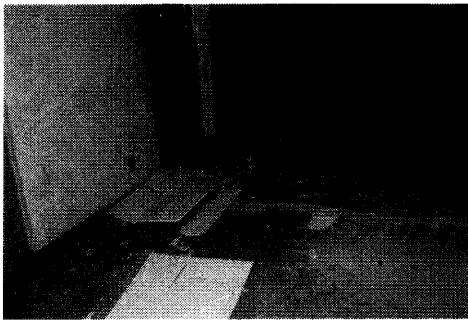
写真-12～14. 地震直後の校舎3号館2階廊下・教室床の亀裂
