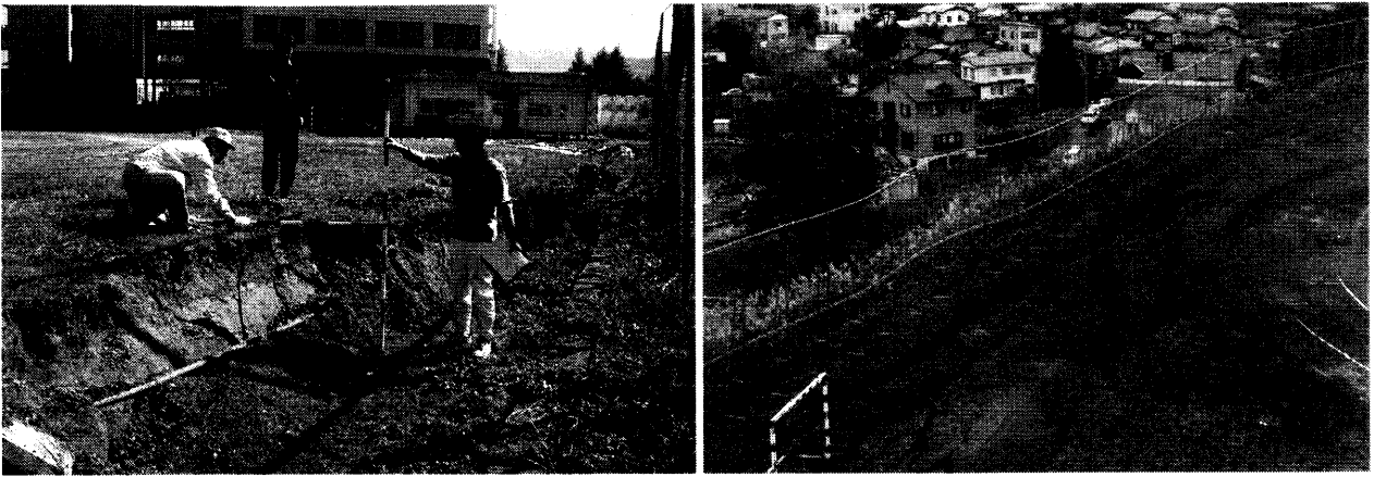
写真-2, 3. グラウンド西側～南西側の亀裂, 歪むフェンス
