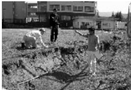
グラウンド南側に生じた地割れ
