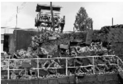
校舎3号館南側のブロックの崩壊
