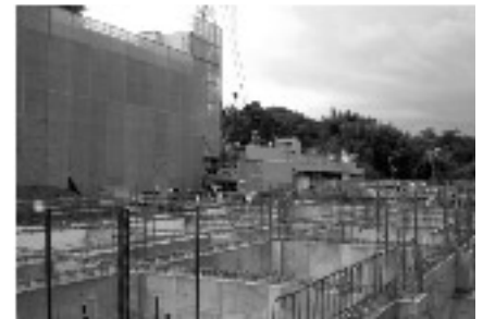
学生寮(高志寮3号館の新築工事)
