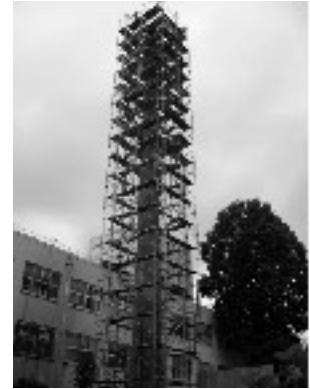
解体される煙突
