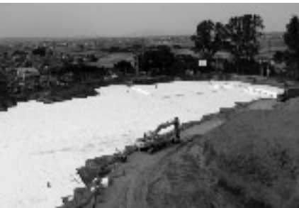
グラウンドの超軽量化工事のため、一面に敷き詰められた発泡ポリスチレン大型ブロック
