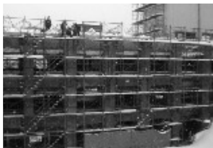
大雪の中進められる恒久復旧工事(1)
