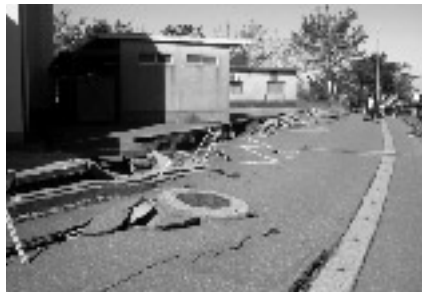
大きく傾斜した学生寮への道路
