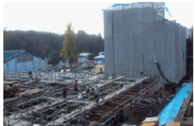
新3号館造成工事の様子(11月14日)
