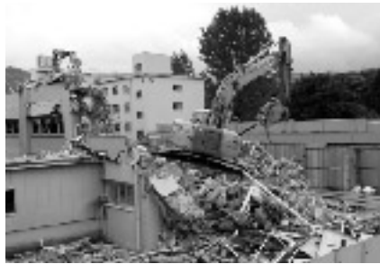
取り壊される学生寮(高志寮)3号館
