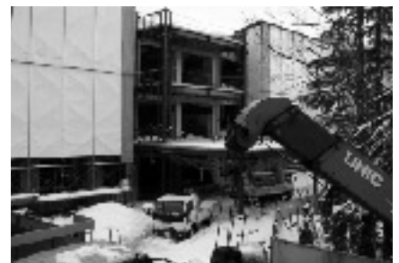
大雪の中進められる恒久復旧工事(2)
