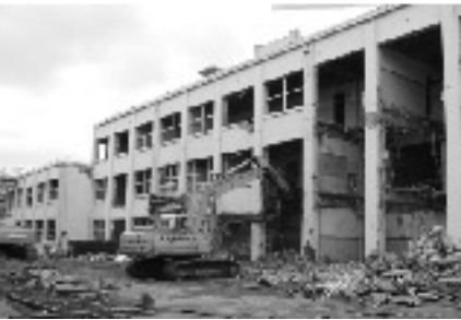
取り壊される校舎3号館
